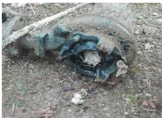
État d'une pompe avant nettoyage
